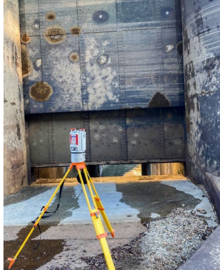
Abb. 3: Laserscan der Obertafel als Referenzmodell, durchgeführt während einer Trockenlegung des Kanals.
