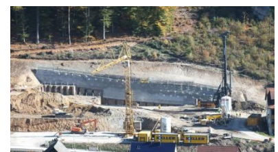
Hotel-Sponsel-Regus, Heiligenstadt, Baugrubensicherung
