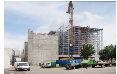
Neubau Hochregallager, Audi AG, Ingolstadt
