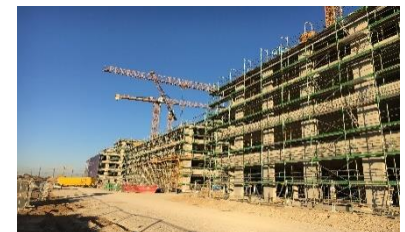
Neubau Bürogebäude, GFK, Nürnberg
