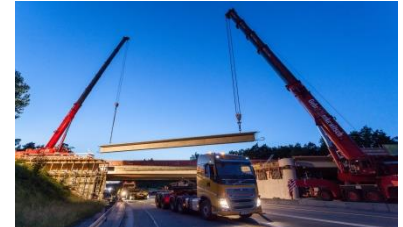
BAB A3, Frankfurt-Nürnberg Teilerneuerung Überführung
