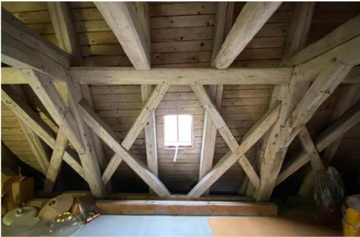
Foto der Stuhlkonstruktion im gezeichneten Kehlbalkendach von Larissa May
