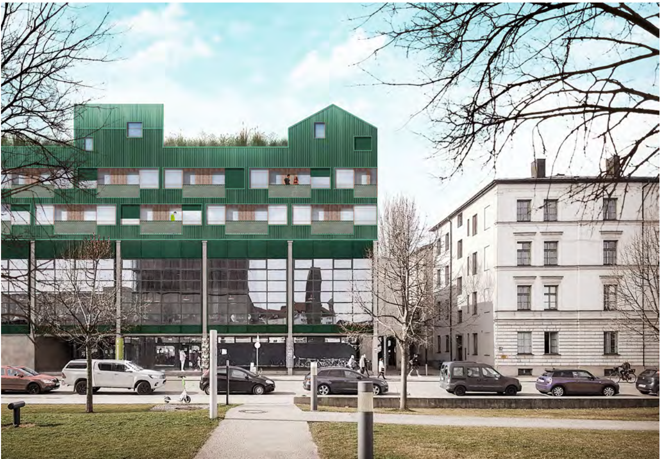
Mit der Erweiterung in 1975 wurde auch die Fassade neukonzipiert dennoch wurden gestalterische Elemente von F. Hart weitergeführt massive Stützen, feingliederte Fensteröffnung und breite horizontale Bänder, die das Gebäude optisch kleiner wirken lassen.
