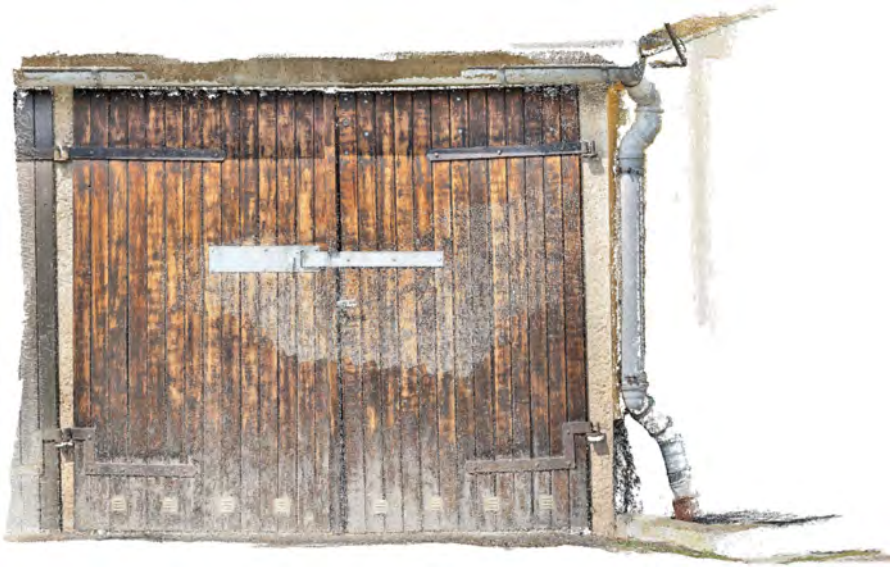
Punktewolke Garagentor von Michi Beisle und Victoria Bilewitz
