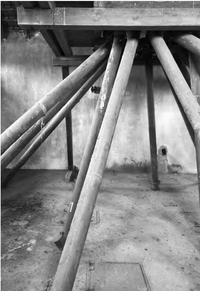
Die Verteilerkonstruktion diente dazu das Getreide in die einzelnen Kammern des Getreidesilos zu befördern. Als wichtiges historisches Element wird die skulpturale Konstruktion künftig wieder für Besucher zugänglich sein.
