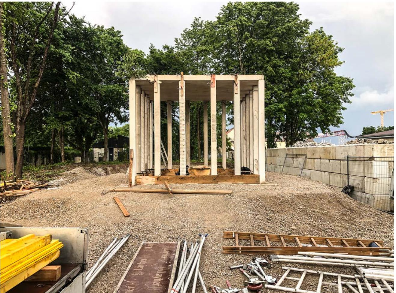
Wahlpflichtfach Sichtbeton; Der fast fertige Pavillon. In gemischten Gruppen wurden die Fertigteil-Stützen mit wiederverwendeten Schalungsmaterialien (Altreifen, Kleidungsstücke, Eierkartons, Verpackungsmaterial u.v.m) von den Studierenden geschalt und später teils steinmetzmäßig oberflächenbearbeitet.
