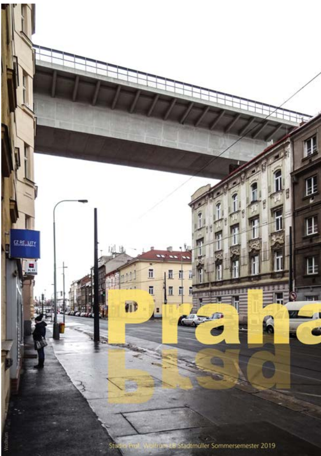
Masterstudio Prag, Planungsgebiet: Der Raum unter der Autobahn- und Metro-Brücke über das Nusle-Tal, Foto: Arthur Wolfrum
