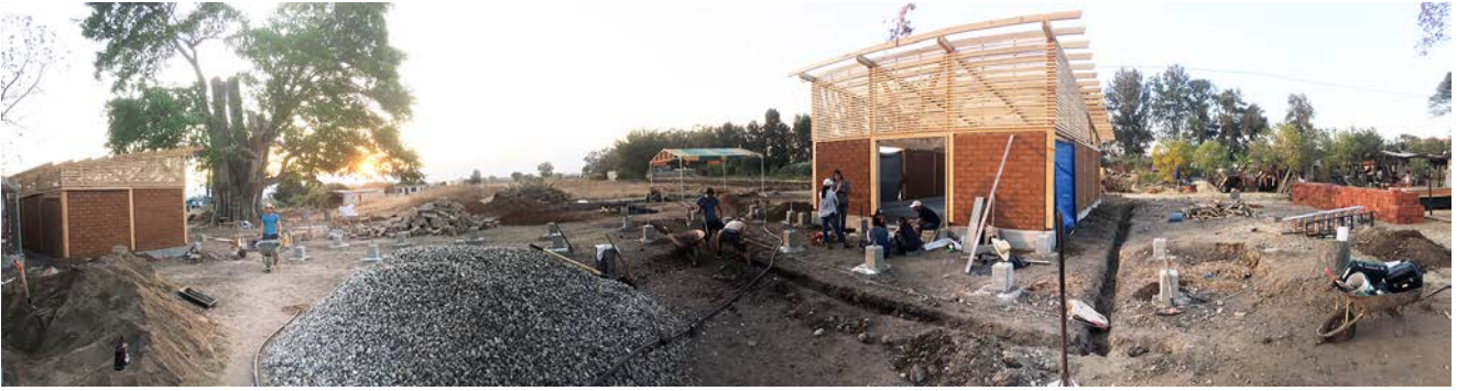
Quiané DesignBuild Mexico, Baustelle Anfang der letzten Bauwoche, links das Sanitärgebäude, rechts die Aula, Foto: Quiané DesignBuild Mexico
