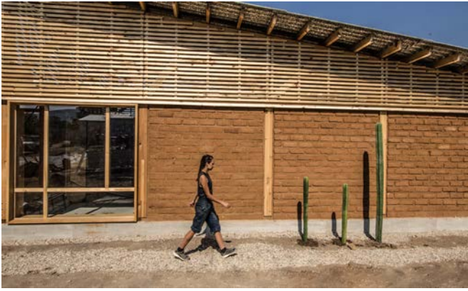
Quiané DesignBuild Mexico, Seitenansicht der Aula, Foto: Paulina Ojeda
