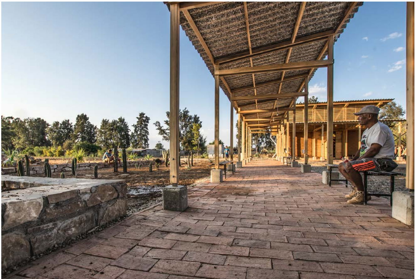
Masterstudio DesignBuild, WS 2018/19: In diesem Jahr wurde ein Zentrum für Kultur und Ökologie in Santa Catarina Quiané, Mexiko mit einer ersten Bauphase realisiert. Der Holz- und Lehm- und Lehm-Bau wurde zusammen mit der Gemeinde, der lokalen NGO CAMPO a.c. und der Universität La Salle, Oaxaca realisiert. Studierende der Hochschule München: K. Baron, K. Bauer, R. Caizergues, M.J. Chiriboga Ramirez, A. Goncalves da Silva, F. Hecht, L. Holzapfel, A. V. Kozma, M. Kurz, A. Matulla, O. Petrenko, D. Rader, T. Reiner, M. Rottenwaller, P. Sauer, P. Streit, F. Stuffer, M. Tichy, J. Weise, H. Wiesenfeld, M. Yücesan. Studierende der La Salle University: J. Morales, I. Ramirez, N. Reyes, A. Rodriguez. Lehrende + ExpertInnen: L. Burbano, S. Oviedo (Atarraya Taller de Arquitectura); Prof. Dr. J. Jungwirth, LB F. Loserth (Bauingenieurwesen), P. Ojeda (Fotografie), LB Dr. H. Strobl (Dokumentation). Galerie und Kakteengarten, Foto: Paulina Ojeda
