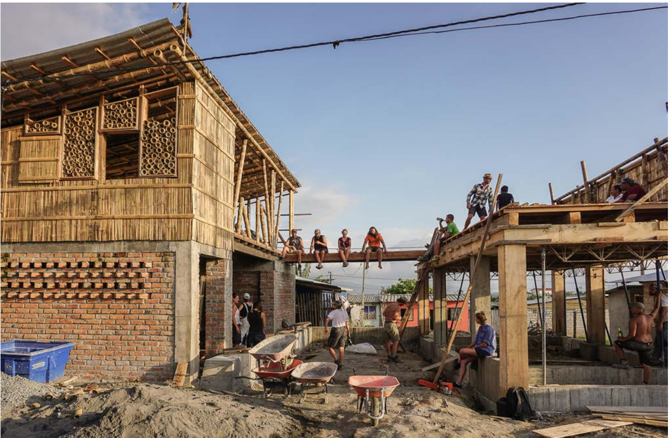
17 - Fertiges Kulturzentrum 18 - Während der Bauphase
