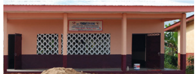
Das neue Schulgebäude in Dschang kurz nach der Fertigstellung
