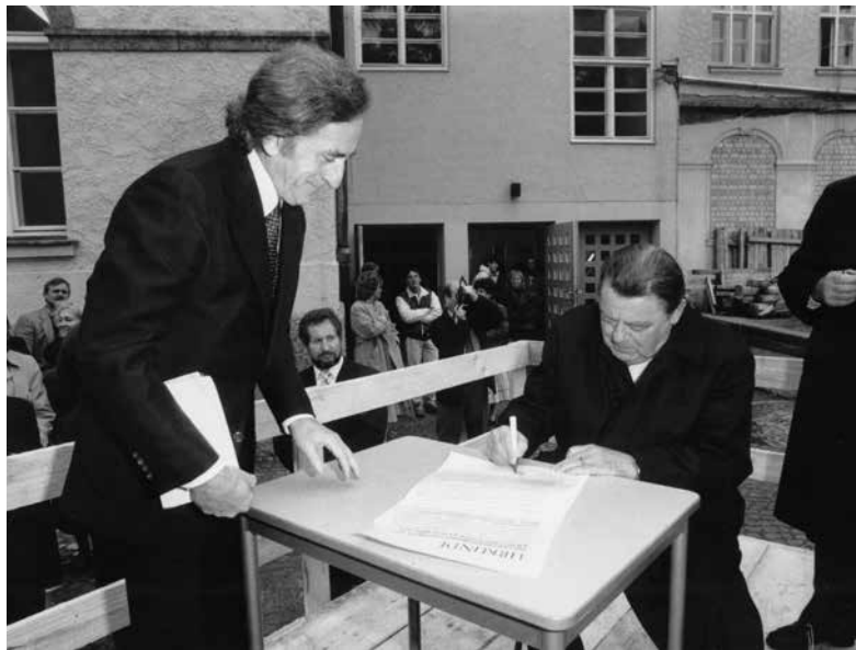
28. Oktober 1987: Präsident Keßler und Ministerpräsident Franz Josef Strauß bei der Grundsteinlegung für die Erweiterungsbauten an der Lothstraße (G- und H-Bau).
