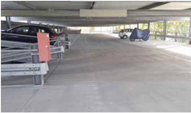
Parkhaus in Additivdeckenkonstruktion aus Stahlblechen und Stahlbeton
