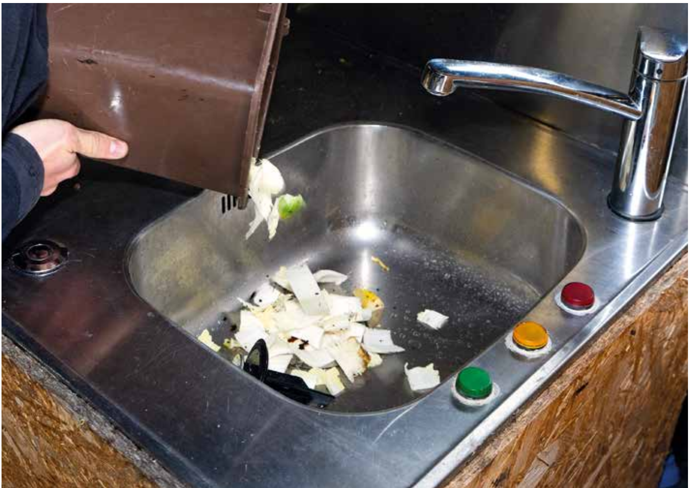
Der Biomüll kann einfach in der Spüle entsorgt werden und wird im Smart-Degrader zu Energie umgewandelt
