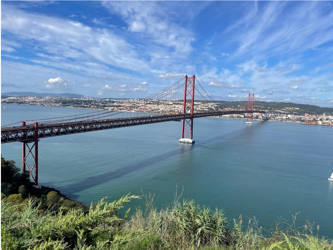
Bild 1: Die berühmte Brücke von Lissabon (Ponte 25 de Abril)
