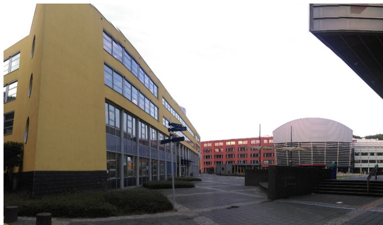
HAN Campus in Arnheim mit Automotive Gebäude links
