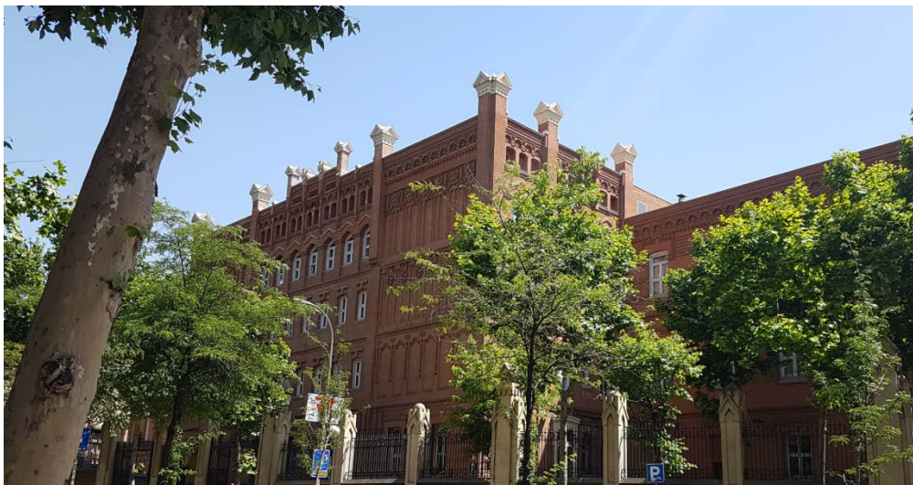
Gebäude der ICAD E
