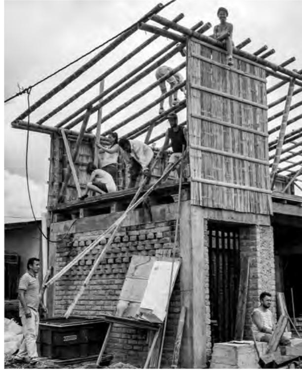
» Licht und leicht: das Obergeschoss aus Bambus
